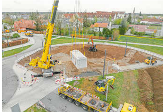
Die 35 Tonnen schwere Brunnenstube mit dem Verteiler für die Fontänen schwebt ein.
