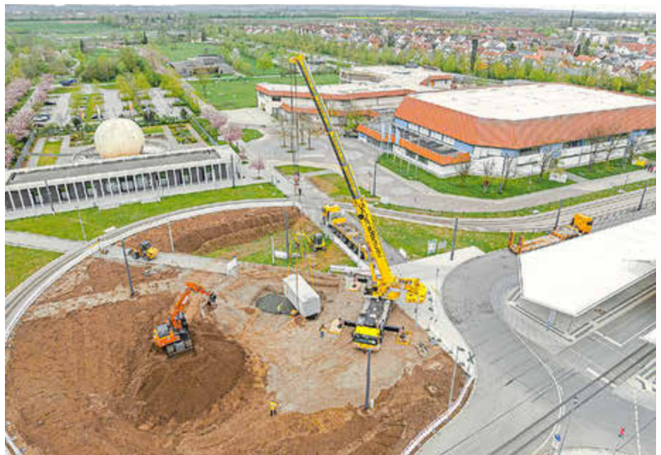
Die geplante Neugestaltung der Wendeschleife führt den Grünbereich des Sport- und Freizeitparks West harmonisch weiter Richtung Osten. Fotos: ABOUT US
